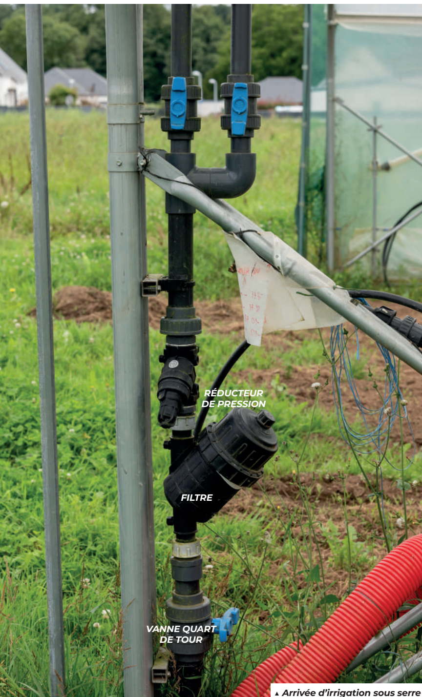
▲ Arrivée d'irrigation sous serre
